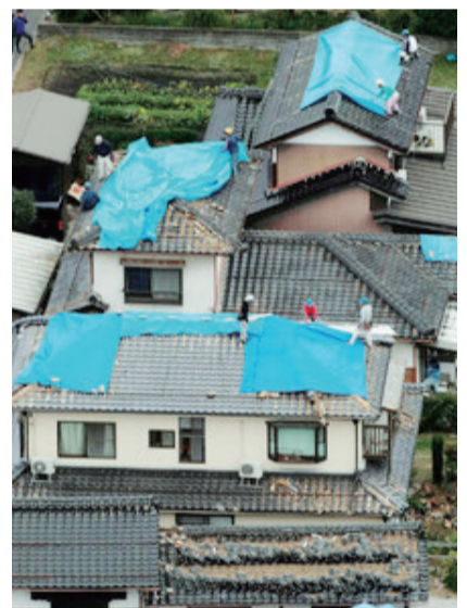
損壊しブルーシートに覆われた建物が多く見られる
