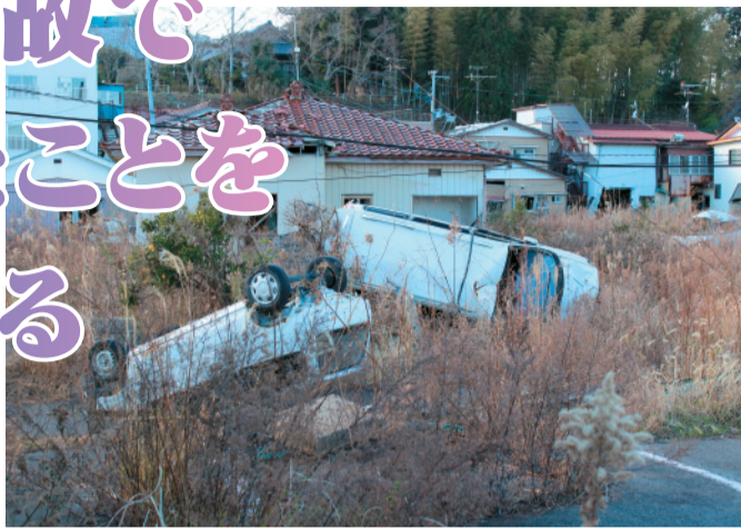
居住制限区域には壊れた家屋や車両は放置されたまま
