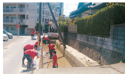
職員有志で用水路の土砂撤去を行った。土嚢袋にして約1200袋分もあった
