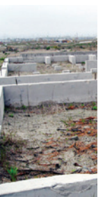
全てが津波で流された家の土台だけが残った
