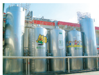
グリーンコープ専用の貯乳タンク
