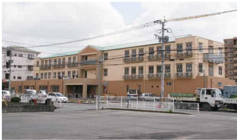
竣工間近の抱樸館福岡のようす
