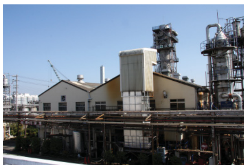
ミヨシ石鹼(株)神戸工場 1996年の阪神淡路大震災で壊滅的な被害を受けた。しかし、確かな技術と人材は健在、見事に再建した
