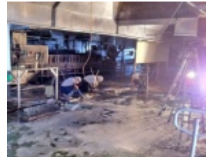
高橋徳治商店の工場の瓦礫撤去やヘドロの清掃に、グリーンコープの職員もボランティアで協力しました。
