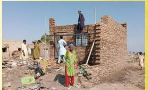
家屋の建設中
