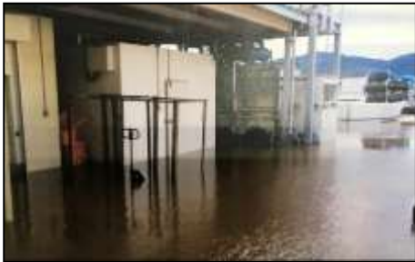
工場1Fが1.5メートル程水没 機器も水没してしまいました。
