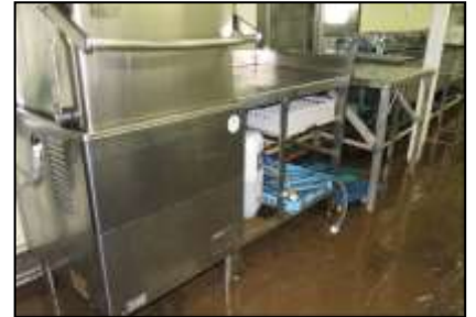
工場全体が浸水し、機器も浸水して しまいました。
