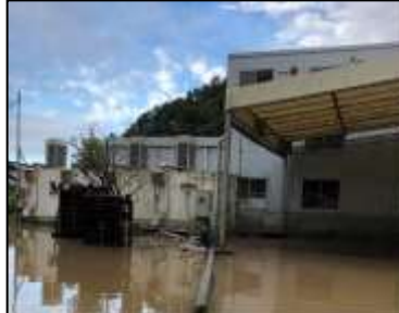
工場1Fが1.5m位水没して しました。
