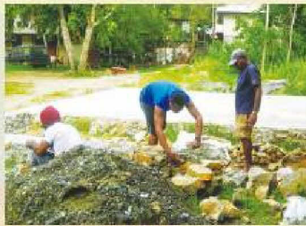
パプア農村コミュニティ発展財団 (YPMD) の敷地に、コンテナを設置するための土台を作りました。
