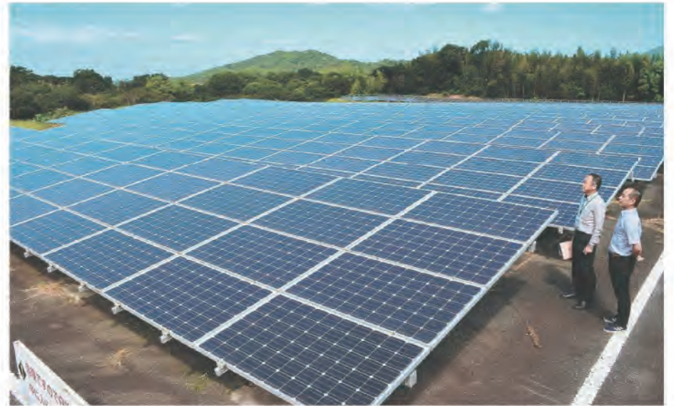
太陽光発電パネル4228枚が並ぶ神在太陽光発電所＝福岡県糸島市
