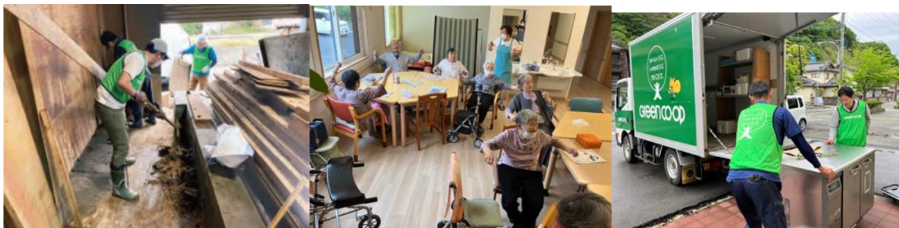
土砂出し作業
