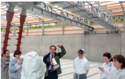
堆肥2次発酵槽。臭いのない完熟堆肥を作る設備。
