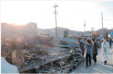
火災に遭った輪島市の朝市通り付近を視察。
