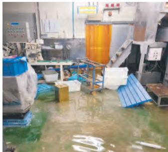
工場内が浸水し、機械の故障などが発生しました。
