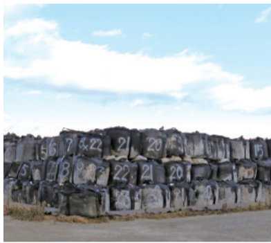
▼福島県沿岸部のいたる所にある除染土の仮置場。除染土が入ったフレコンバッグが積み上げられている。
