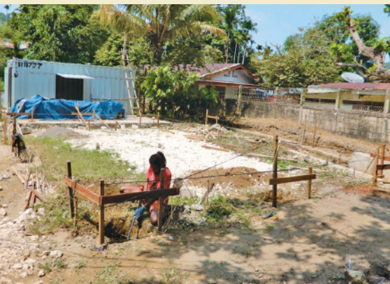
奥はキッチンとなるコンテナ、手前がカフェ飲食スペースの建設予定地
