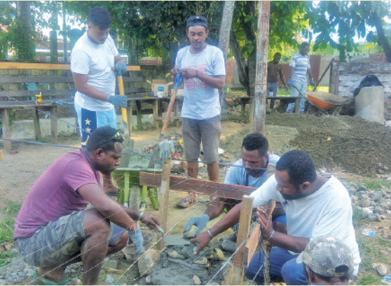
みんなで力を合わせて基礎工事
