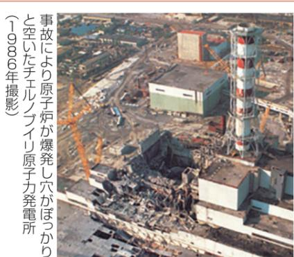
事故により原子炉が爆発し穴がぼつかりと空いたチェルノブイリ原子力発電所 (1990年撮影)
