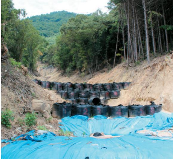
土嚢とブルーシートを施した土砂災害の跡 (2015年8月16日撮影)。砂防ダムの建設には相当の時間がかかる予定
