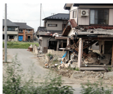
石巻市の被災した住宅地。1階部分は津波が突き抜け柱を残し、空洞と化した。元の姿を保つ2階部分と明暗が分かれる。街全体、同じ様な光景が続く。人影はない。「黒い壁」と呼ばれる津波の恐怖を感じる
