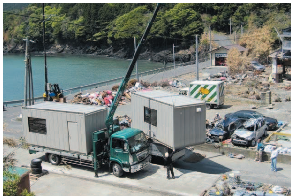
蛤浜に、共同プロジェクト・ボランティアスタッフの拠点と物資保管庫としてプレハブ2棟を設置しました
