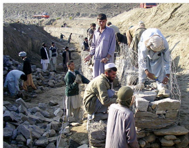
用水路作り 日本の伝統工法の蛇籠を積んでいるところ 人の手で水路は作られていく
