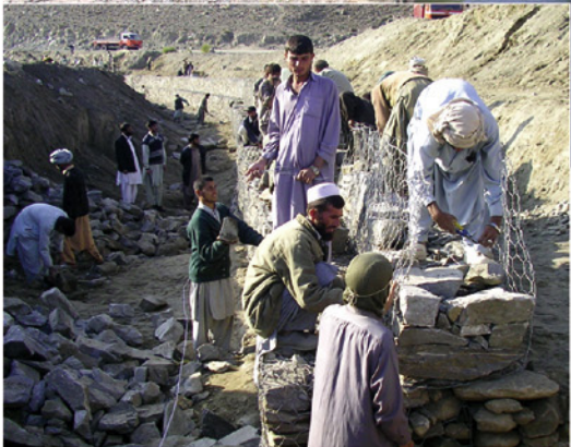
(上) 完成した水路 護岸用に約14万本の柳を植えた (下) 用水路作り 蛇籠を積んでいるところ 人の手で水路は作られていく
