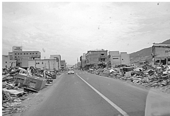
幹線通路は通れるが、周囲は瓦礫の山。 異臭もホコリもひどい状況。(6/21撮影)
