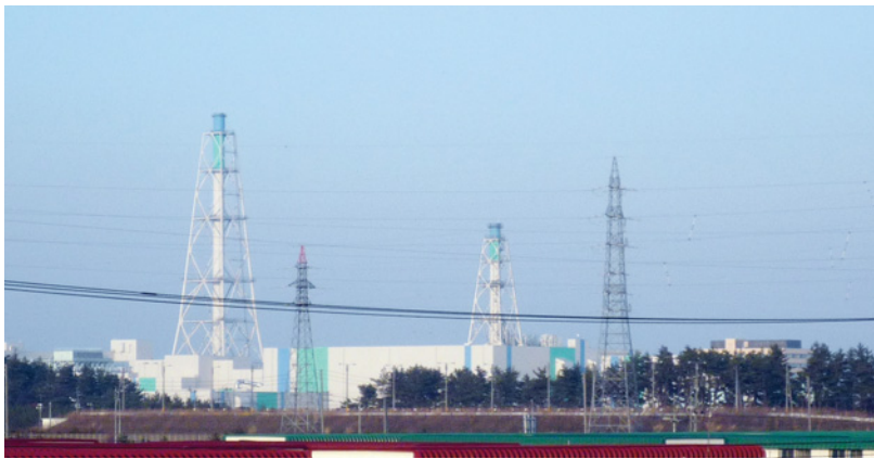
六ヶ所再処理工場
