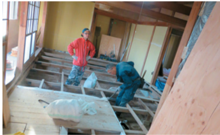
大工ボランティアが床板をはがしている様子
